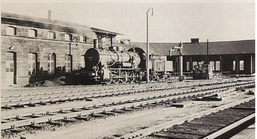
Bild 170: Der ringförmige Lokschuppen mit Drehscheibe und Wasserkeran und die Ostbahn-Wagenremise, 1955; Lok G 10, Betriebsnummer 57 1390
